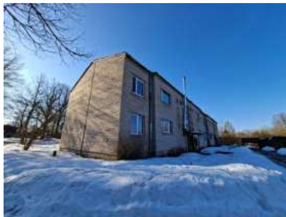
Dzīvojamā māja Stacijas ielā 7
