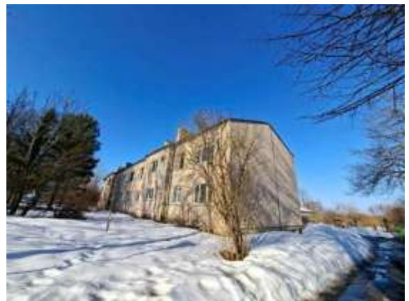
Dzīvojamā māja Stacijas ielā 7
