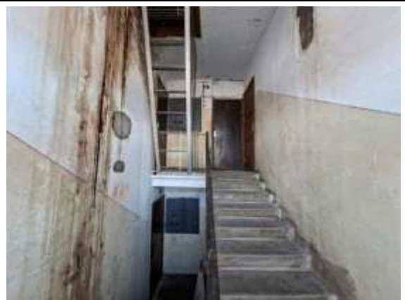
2.stāva kāpņu telpa
