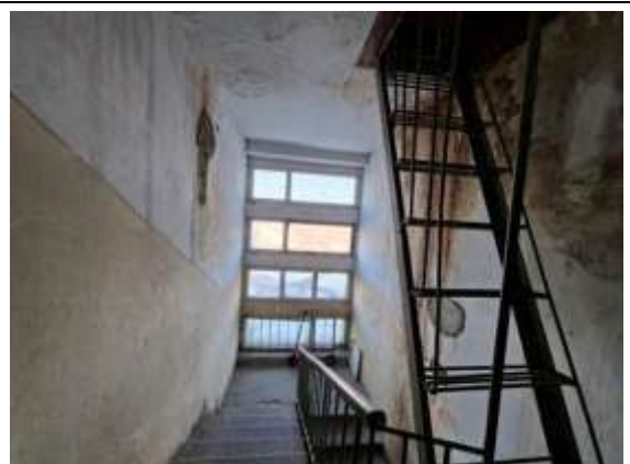
2.stāva kāpņu telpa
